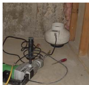
Fig 3-25 Fan used to check PFE
